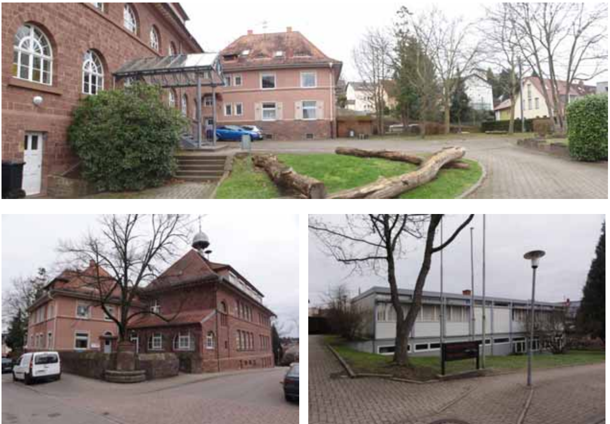
Abbildung 40: Ausgangssituation im Bereich des Alten Schulhauses und des Funktionsgebäudes
